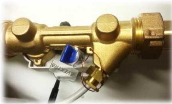
Рисунок 1. Пломба на проточной части.
