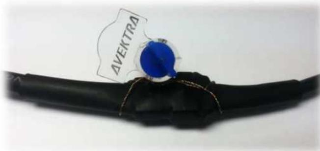
Рисунок 3. Пломба на электрической магистрали проточной части.
